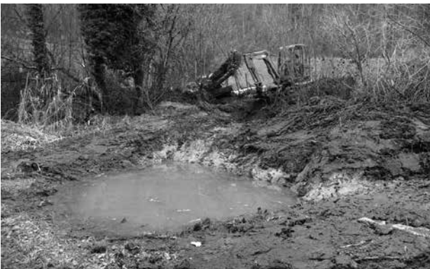
Neu erstelltes Becken in der Bacheren
