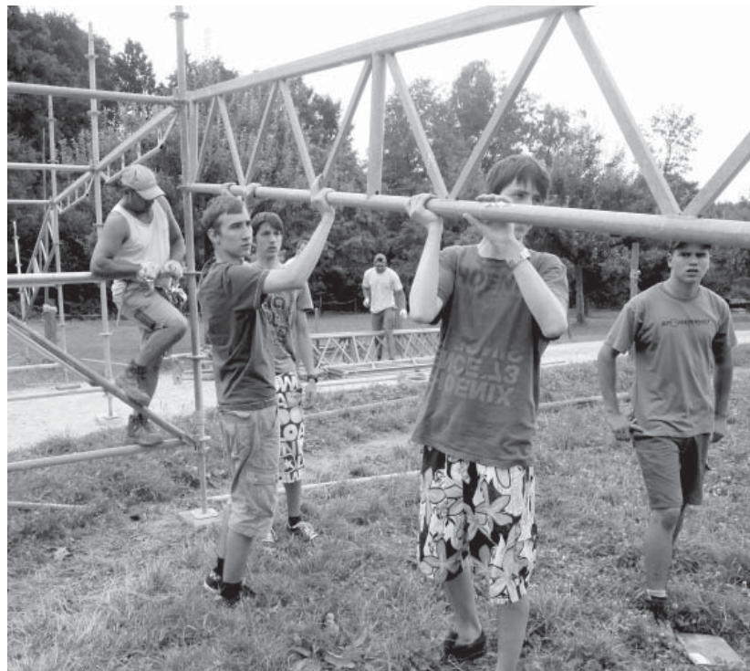
Jugendliche beim Aufbau der Rampe
