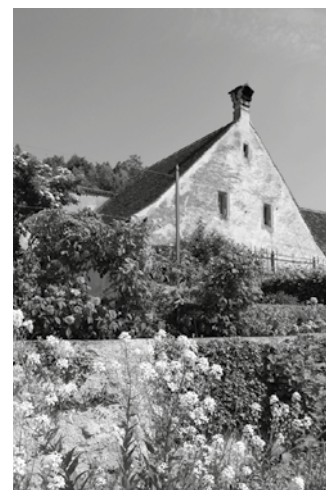
Aussenansicht einer Mönchsklausel
