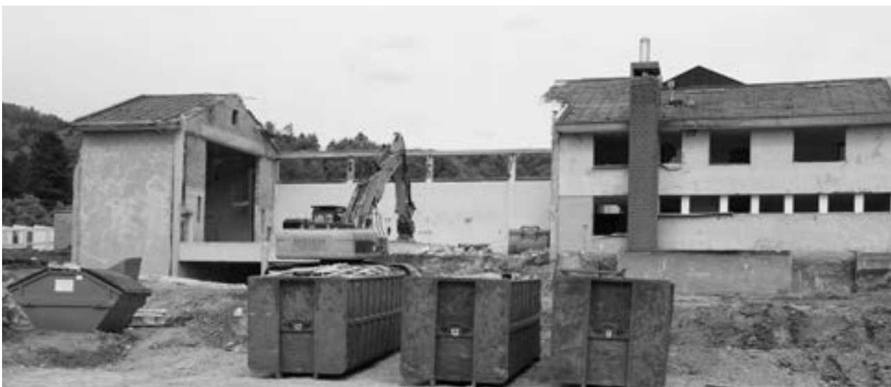
Die alte Turnhalle wird abgerissen
