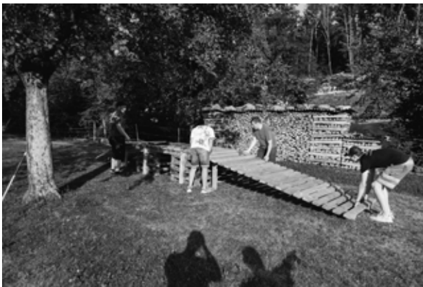
Die aufgebaute Rampe wird ausgerichtet.
