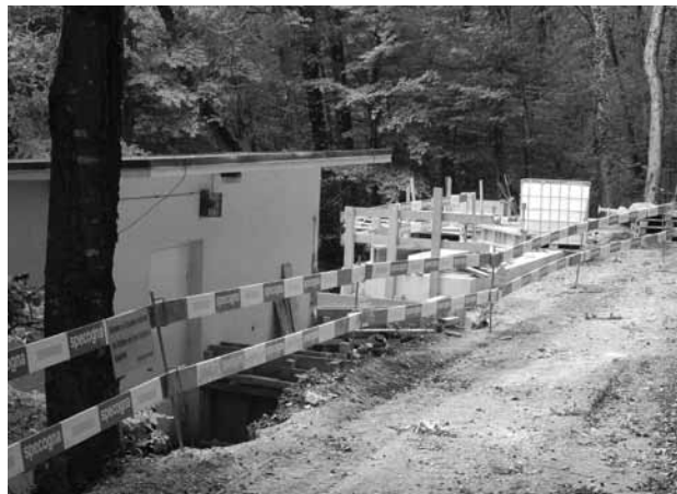
Baustelle Skyguide Lägern
