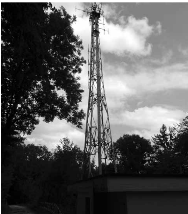
Baustelle Skyguide Lägern
