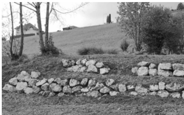
Die fertige Mauer mit viel Platz für Amphibien
