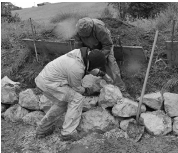
Die Amphibienmauer wird gebaut
