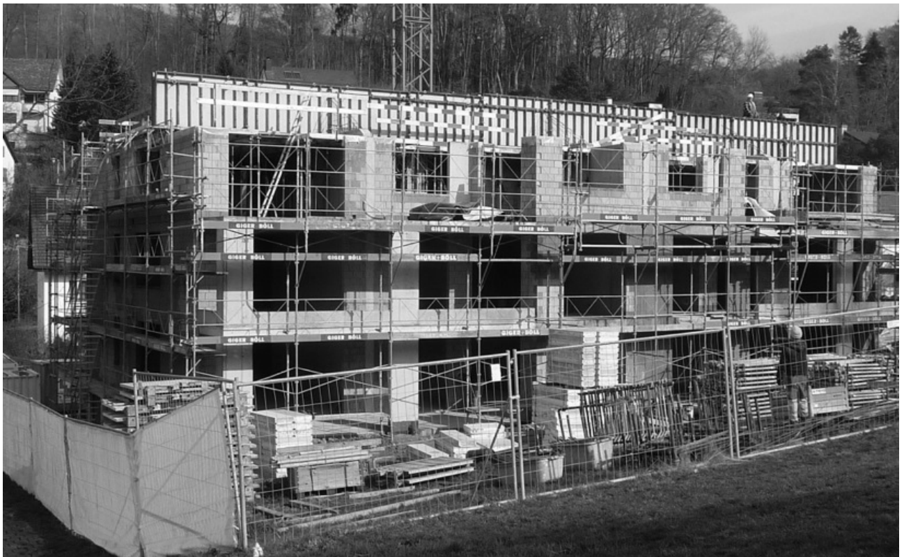
Baufortschritt vom Wohnen im Alter
