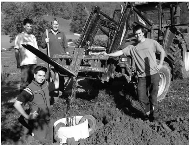
Mike Mani, Marco Camastral und die Gebrüder Fabian und Dominik Oetterli installieren den Stromtunnel zur Start-/Zielanlage des GP Maierisli
