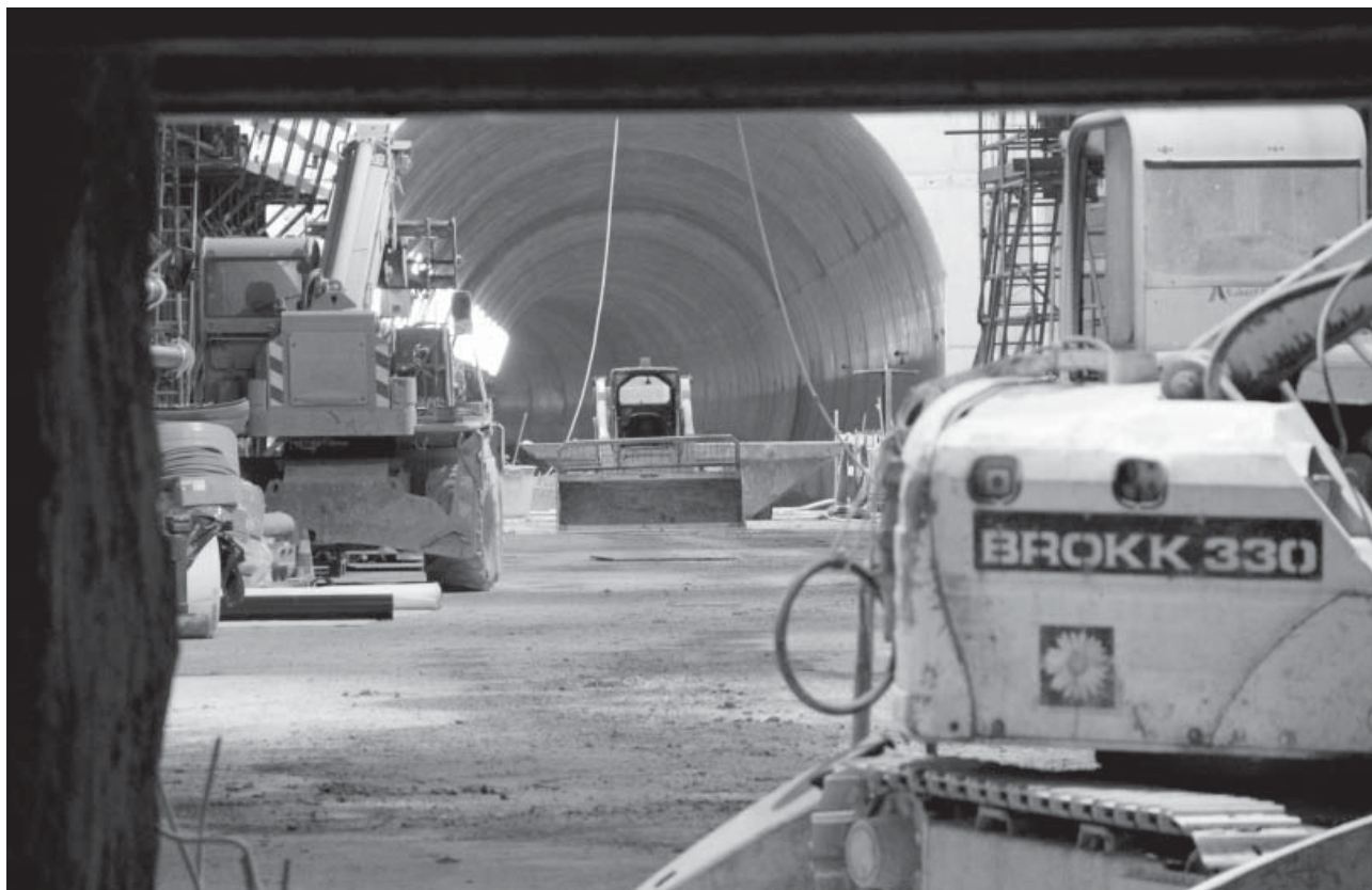
Blick über die Baustelle zur grossen Tunnelröhre
