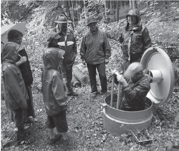
Brunnenstube oberhalb Hochwachtfuss
